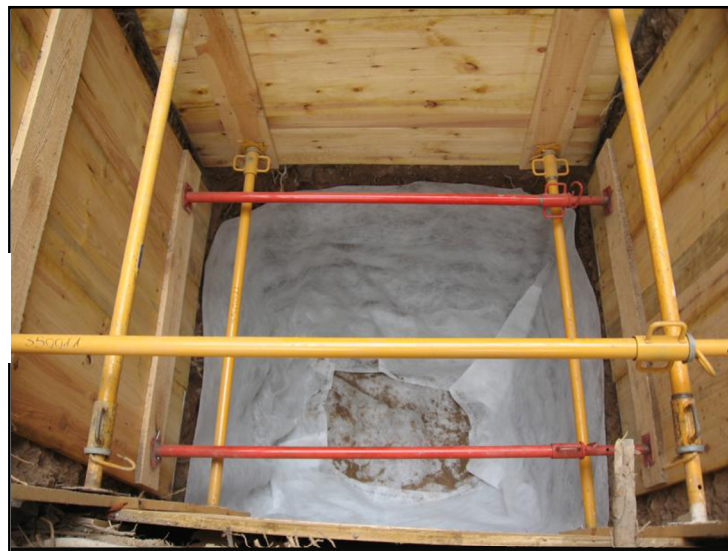
El sondeig un cop finalitzat i tapat amb geotèxtil.
