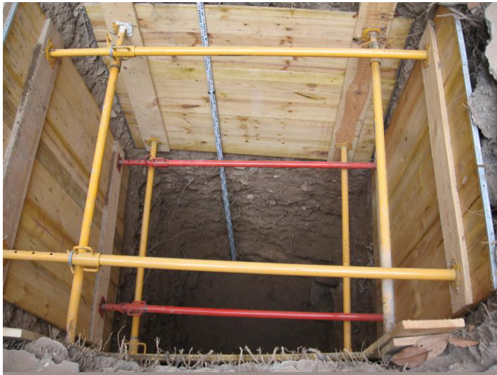
Finalització dels treballs de rebaix del sondeig.
